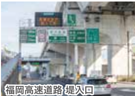
福岡高速道路 堤入口
